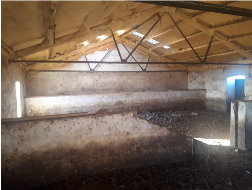
Imagen 12: Fotografía interior nave 6.
