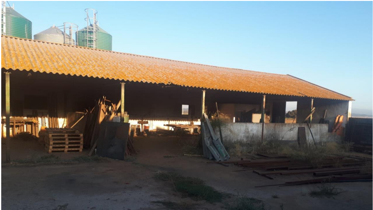
Imagen 10: Fotografía general nave 4.
