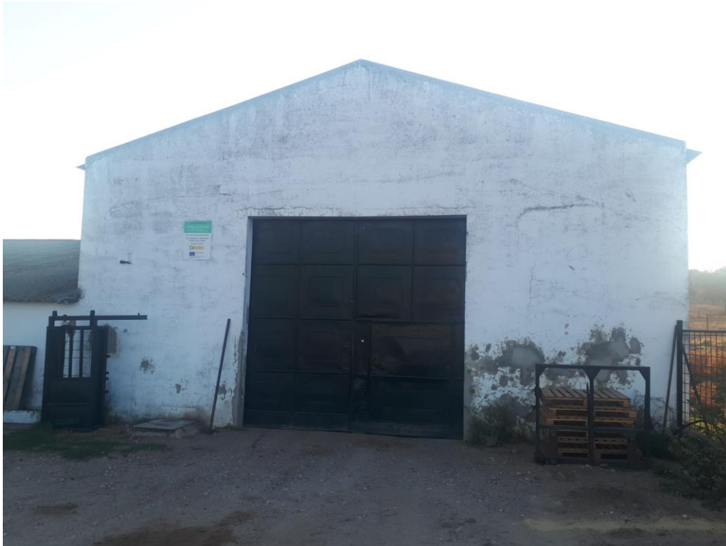
Imagen 9: Fotografía fachada nave 3.
