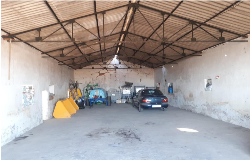
Imagen 11: Fotografía interior nave 5.
