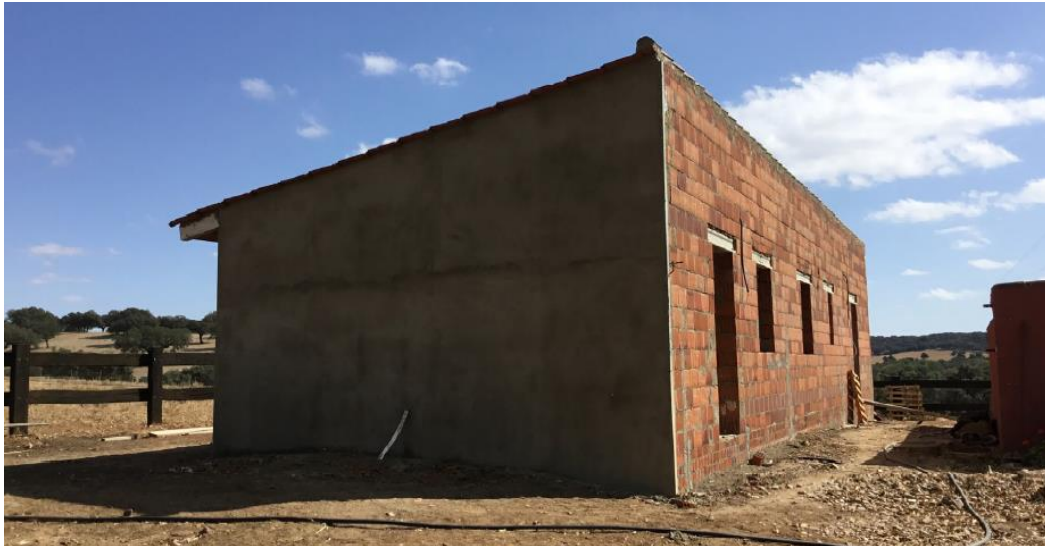
Imagen 13: Fotografía construcción para aseos y vestuario en construcción.
